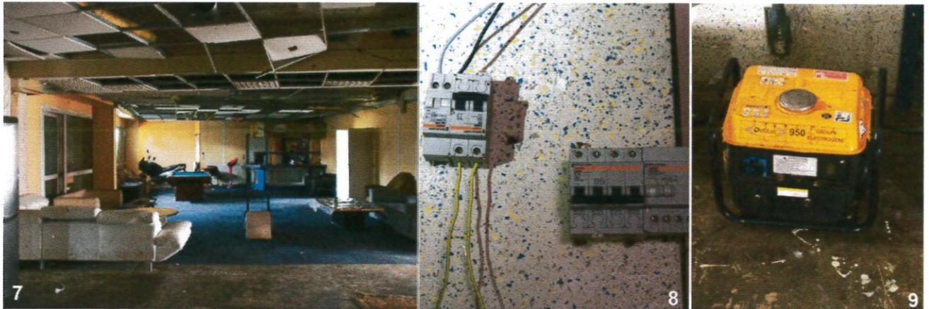
La vaste salle est délabrée (photographie n°7) et contient un groupe électrogène sur alimentation bricolée (photographies n°8 et 9), **l'ensemble** présentant un danger incontestable d'utilisation interdite en local clos - indépendamment de l'alimentation électrique d'origine illécite.
